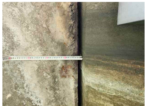
바닥판하면 이동량 측정
