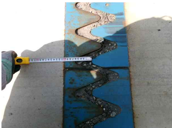
신축이음 이동량 측정
