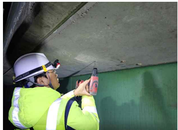
탄산화깊이 측정 현황
